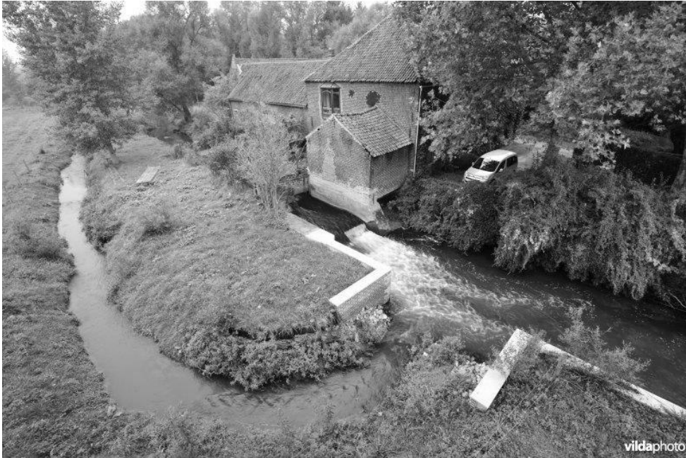
Watermolen met apart zijtraject voor migrerende vissen.
